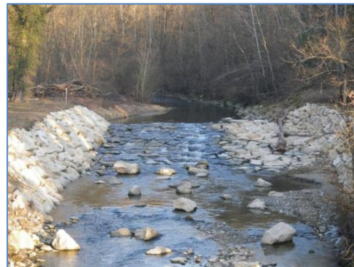
Travaux de réhabilitation d'un seuil en amont du pont de la RD27 au niveau de Chez les Gay
